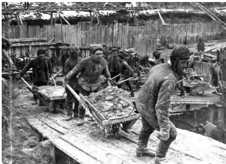
Беломорканал. Вывоз грунта из котлована шлюза. Карельский государственный музей
